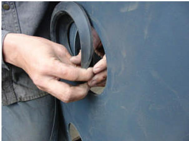
雨水流入口、オーバーフロー用の配管を差し込むためのパッキンを立ち上がり部につけます。使用しない箇所の穴はパッキンをつけた上に蓋を差し込みます。
