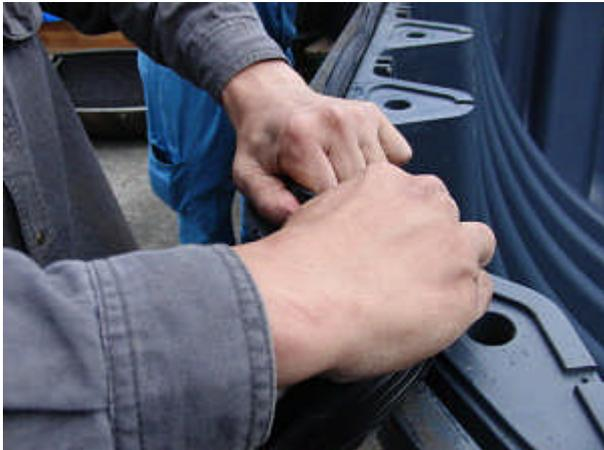
雨水タンク下部側の溝にパッキンを差込みます。しっかりと押し込む必要があります。
